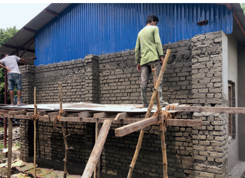
Bau eines Schulgebäudes in Kuleni/Nepal.
