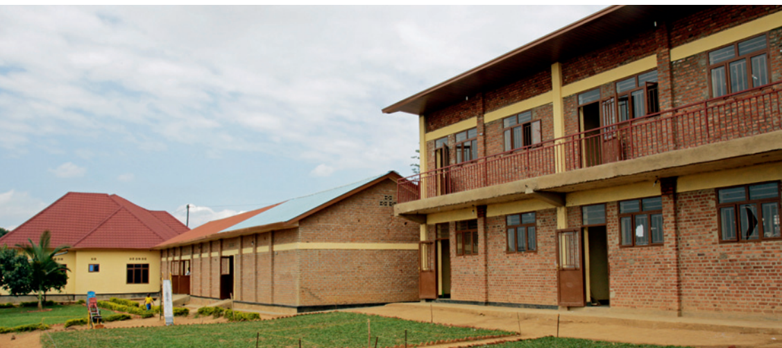
Die Volksschule „Les Génies“ (Ruanda). Mit dem neuen Unterrichtstrakt (re.) können die Kinder ihre gesamte Schulzeit in Ntarama absolvieren – von der Grundschule bis zur Abschlussprüfung.
