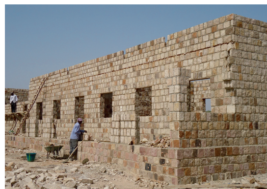
Schulstandort Lougourougombou/Dogonland. Ein neues Gebäude für die Sekundarstufe entsteht (Aufnahme 11/15).
